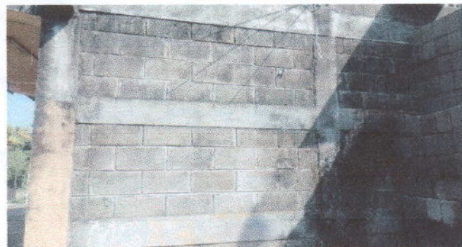
Foto 15: Repello en muro
