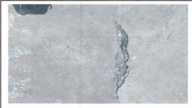
Foto 4: Sustitucion de piso torta de concreto
