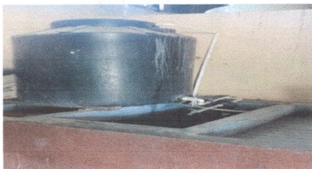
Foto 13: Sustitución de accesorios depósito de agua
