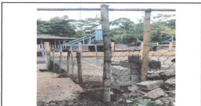
Foto 12: Reparación de tubo HG y malla galvanizada
