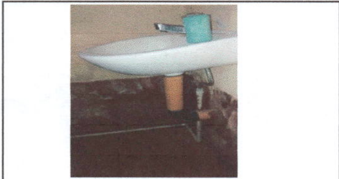
Foto 9: Sustitución de mezcladora lavamanos (contra llave y tubo de abasto)
