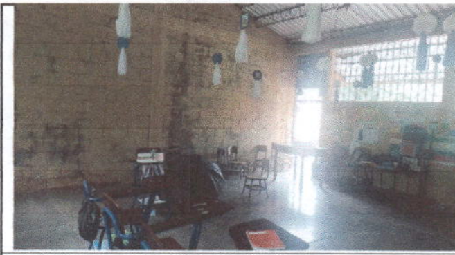
Foto 6: Pintura de muros exteriores e interiores
