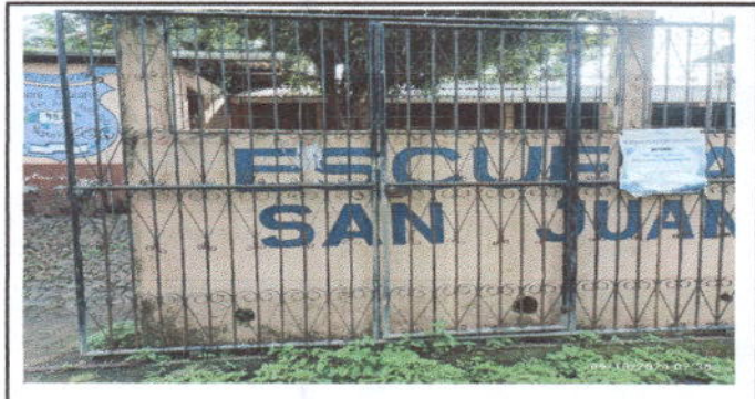
Foto 10: Mantenimiento a portones de metal
