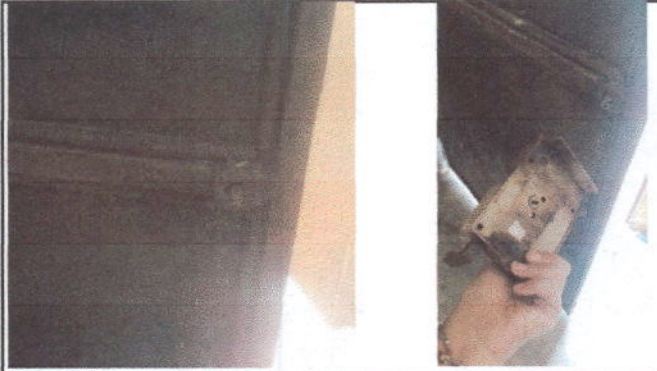
Foto 2: Sustitución de chapa
