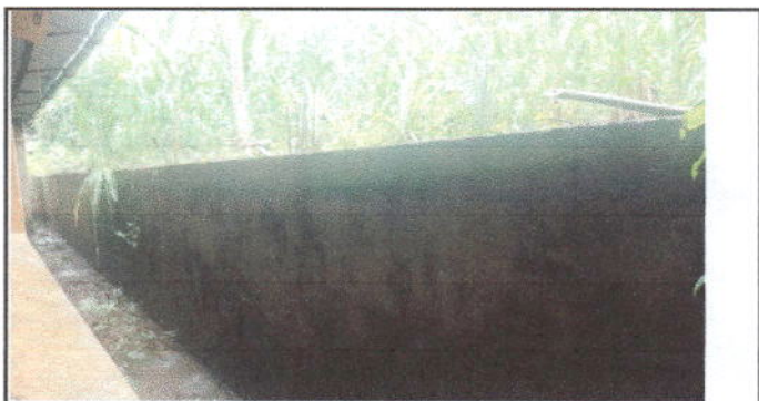
Foto 11: Reparación de muro perimetral de block
