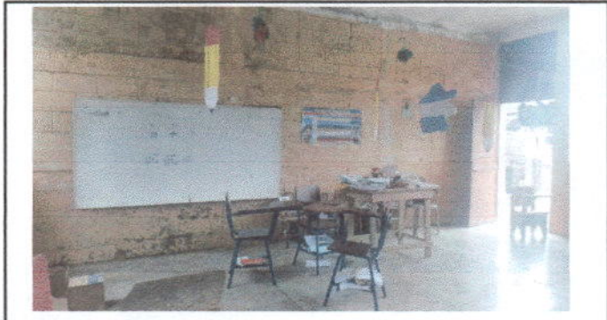
Foto 7: Pintura de muros exteriores e interiores
