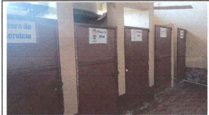
Foto 1: Mantenimiento a estructura (Lijado, cambio de tubo, cepillado, sujeciones, aplicaicones de pintura)
